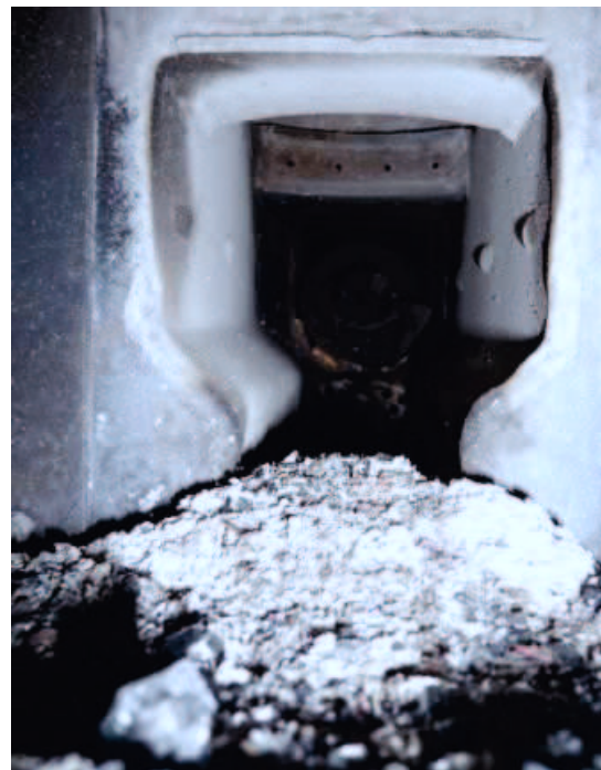
Système de décendrage d'une chaudière domestique
