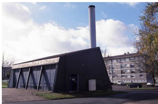
SOCLOVA à Angers (49) – 2.2 MW Source : ADEME
