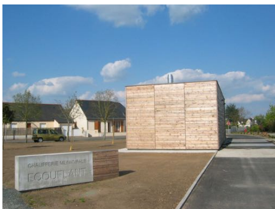
Chaufferie Communale d'Ecoulant (49) 500 kW
