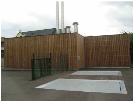
Complexe sportif de Château Gontier (53) – 600 kW - Source : Atlanbois
