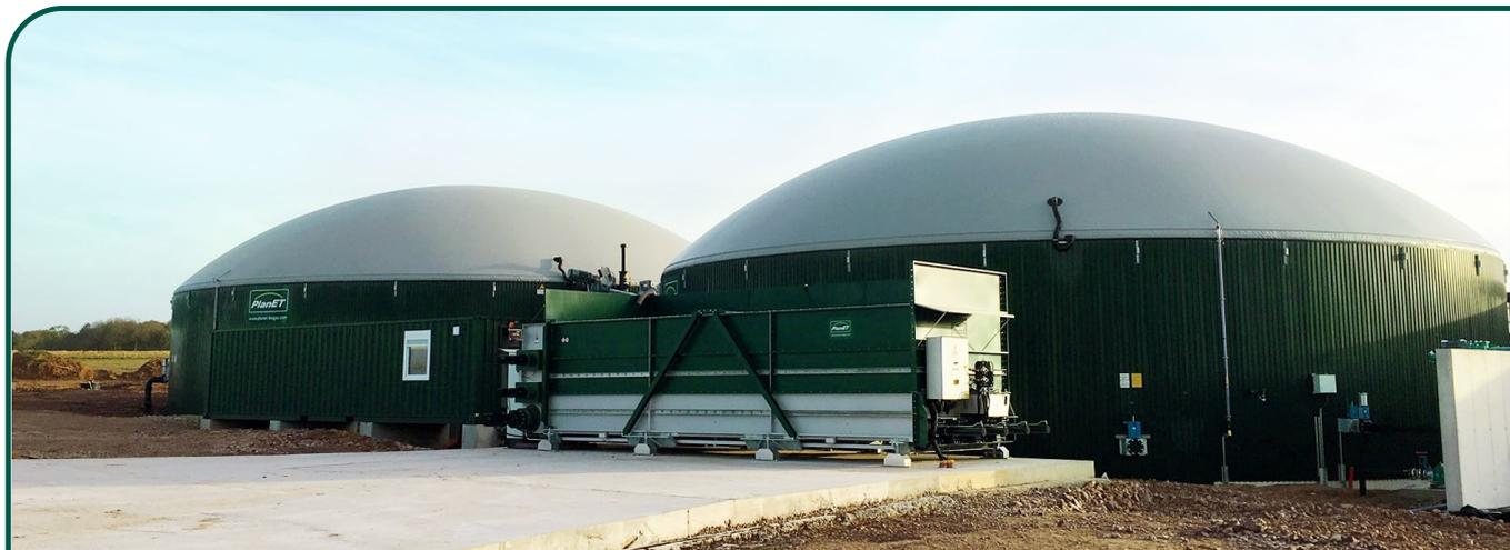
Capacité d'épuration: 170 m<sup>3</sup> biogaz/h évolutive à 210 m<sup>3</sup> biogaz/h | Mise en service: Novembre 2019
