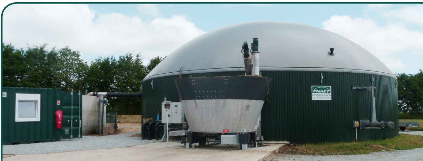
Taille de l'installation: 150 kW | Mise en service: Février 2012
