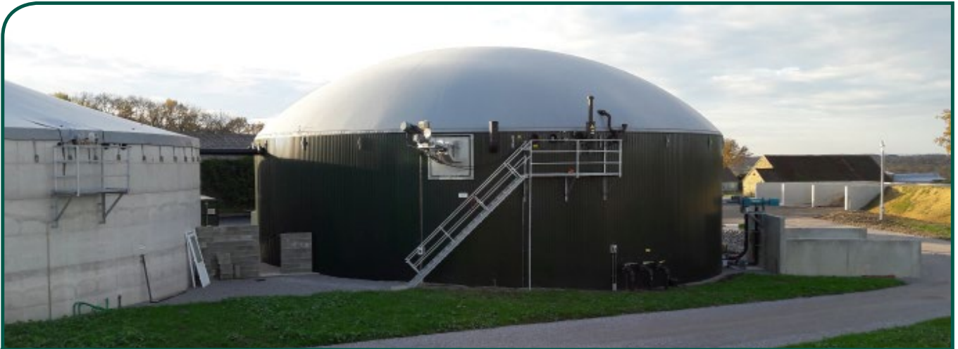
Taille de l'installation: 250 kW | Mise en service: Novembre 2017
