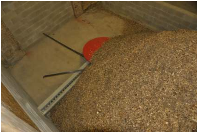
Première livraison de bois à la chaufferie
