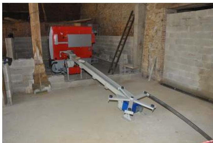
Chaufferie en construction
