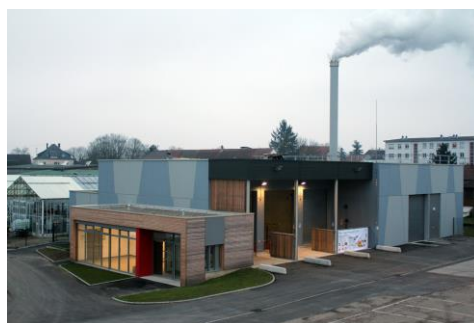
Chaufferie bois de Cernay Crédit photo : ENGIE Cofely
