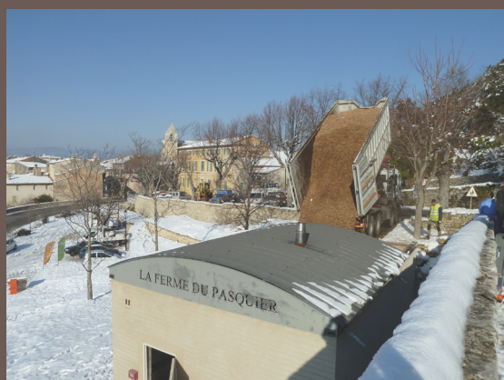
Extérieur de la chaufferie
