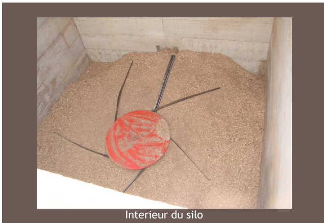
Intérieur du silo
