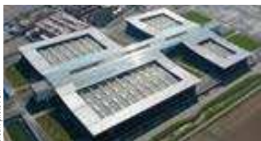
Vue aérienne de l'usine « Joseph Szydowski » de Bordes
