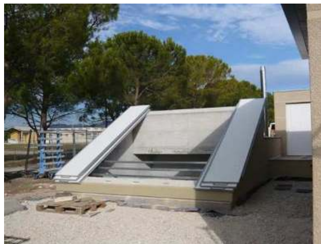
Image 2 : Trappe basculante du silo semi enterré
