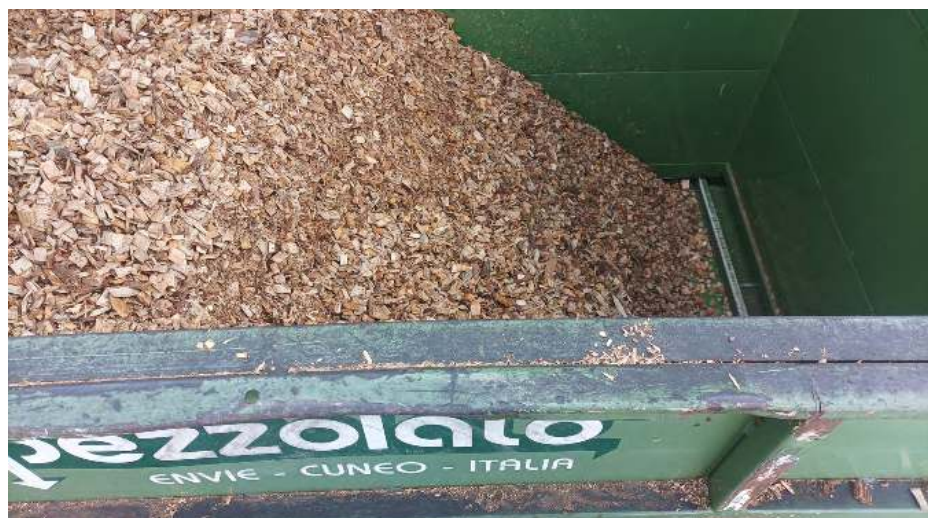
Silo à bois déchiqueté d'une petite chaudière
